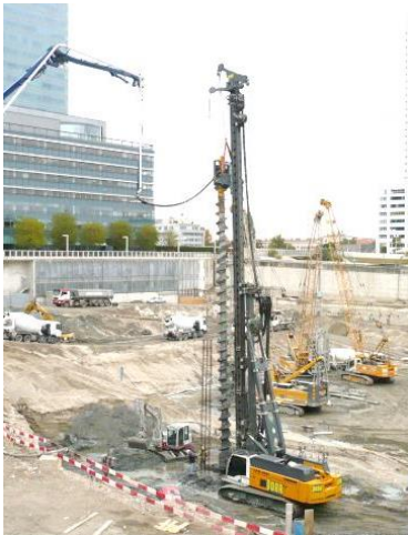
2010: DC 1 Tower CFA piles, Vienna (Austria)
