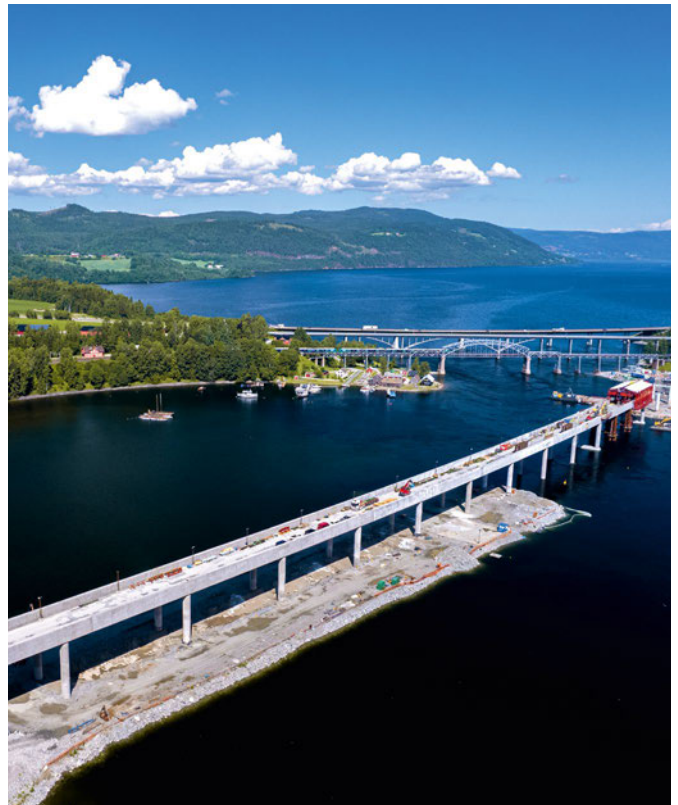
Die Minnevikabridgen ist mit 836 Metern die längste Eisenbahnbrücke Norwegens.
