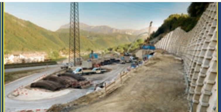
Ein 7 km langer Abschnitt der steirischen S 35 Brucker Schnellstraße wird seit Herbst 2006 ausgebaut. Neben den Straßenbauarbeiten in den zweirohrigen Tunneln Kirchdorf und Kaltenbach, beinhaltet das Projekt auch die Freilandarbeiten.
