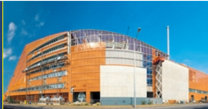
Das optische Erscheinungsbild der Müllverbrennungsanlage Pfaffenau , Wien, wird durch 15.000 m 2 oranges Streckmetall geprägt, das die gesamte Anlage umspannt.
