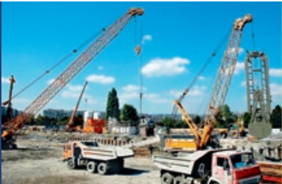
In Budapest, Ungarn, wird die U-Bahnlinie Metro 4 Neke ausgebaut. PORR errichtet drei der zehn U-Bahnstationen: Tétényi út (im Bild), Népszínház utca und Keleti pu. Die Fertigstellung der Rohbauarbeiten ist für Mitte 2010 geplant.
