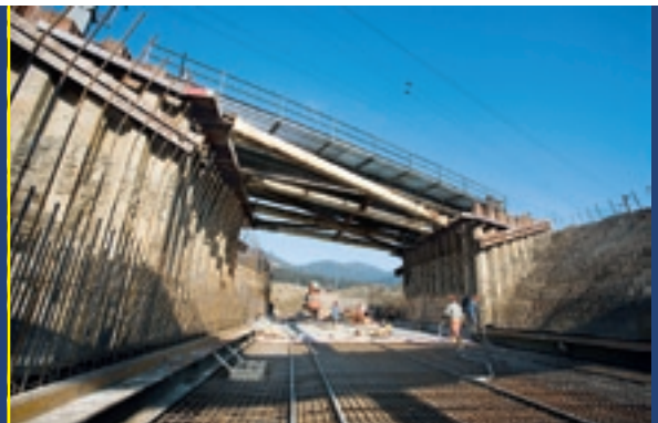
Das Projekt B 170 Umfahrung Brixen in Tirol umfasst die Errichtung einer Unterflurtrasse, von Betriebsgebäuden und Gewässerschutzanlagen, Notausfahrten und Notstiegenhäusern.
