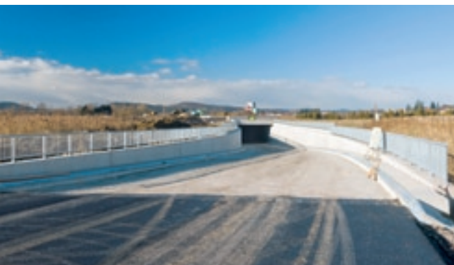
Der Ausbau eines 3,2 km langen Abschnitts der Landstraße B 68 und die Errichtung der Querspange Gnas , Steiermark, entlastet Feldbach und Umgebung. Das Projekt umfasst unter anderem den Bau mehrerer Brücken, eines Lärmschutztunnels sowie Begleitstraßen und Rampen.
