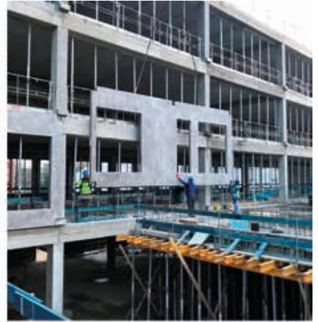
Fertigteile werden gesetzt
